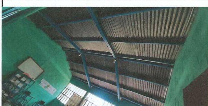
Foto 4: cambio de cubierta de lámina
