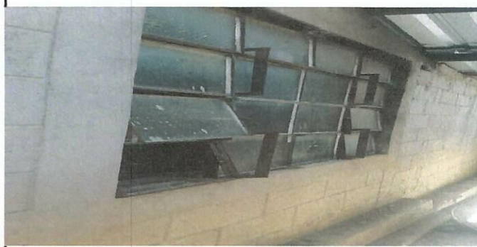
Foto 2: cambio de ventanas cocina
