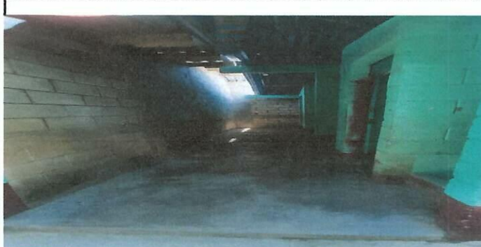
Foto 3: pintura de paredes de baños
